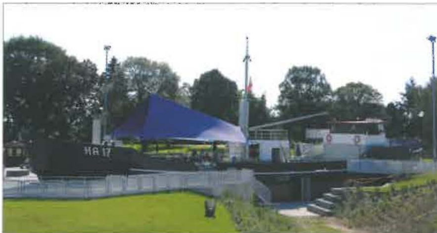
■ Der „Technikraum“ von außen ...
