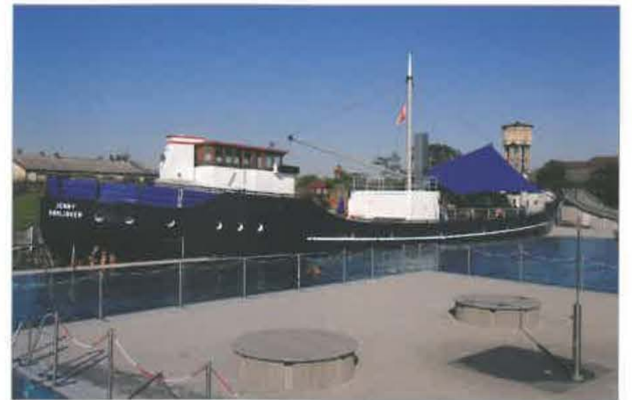
Teilrückbau des Schwimmbeckens und Umnutzung zu Technikräumen
